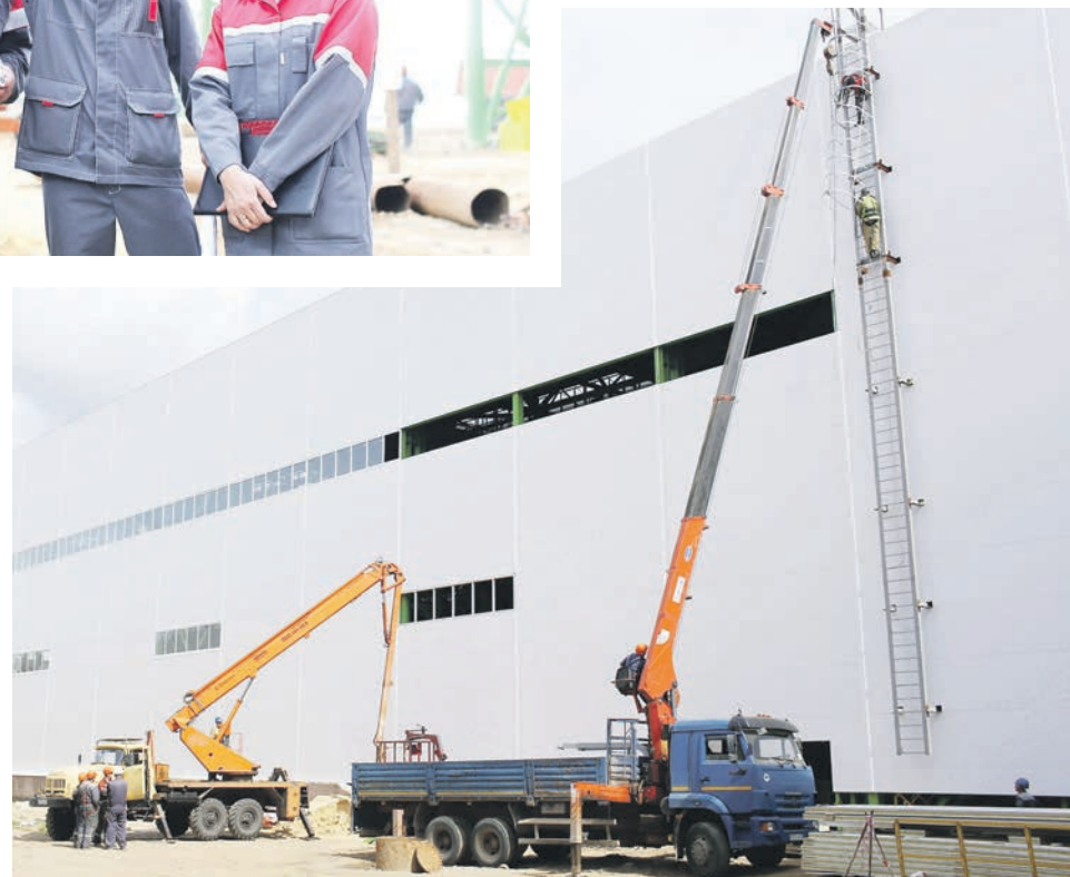
▲ В пятом цехе готовят помещение для нового стана © ВАЛЕРИЙ ПОКУМЕЙКО
